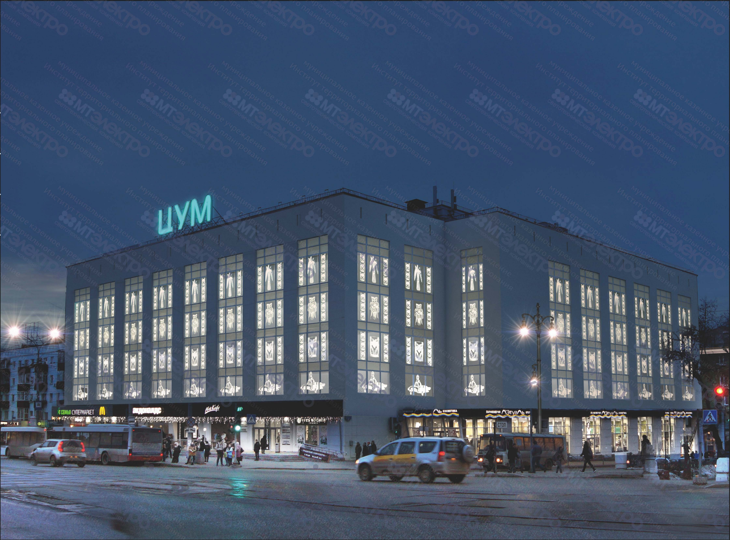
МАКСИМАЛЬНАЯ МОЩНОСТЬ (КОМСОМОЛЬСКИЙ ПРОСПЕКТ 21) 15 кВт
